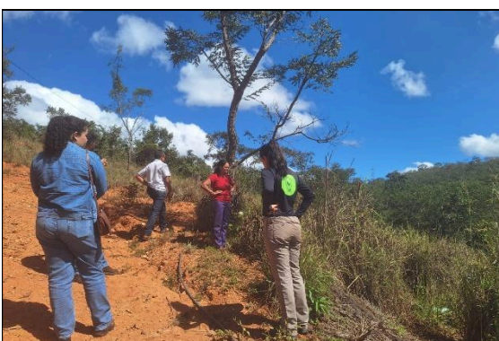
Área degradada em recuperação. Autoria: Luísa Mosqueira Data: 21/05/2025
